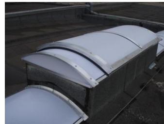
In die neuen Rauch- und Wärmeabzugsklappen mit Zulassung nach DIN EN 12101-2 wurden zusätzliche Elektrische Motoren für das tägliche be-/entlüften eingebaut.
