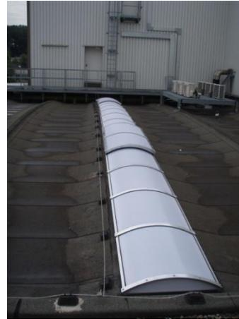
HEMAPLAST wurde gebeten den Hagelschaden der Lichtbänder zu begutachten und erhielt den Auftrag zur vollständigen Lichtbandsanierung
